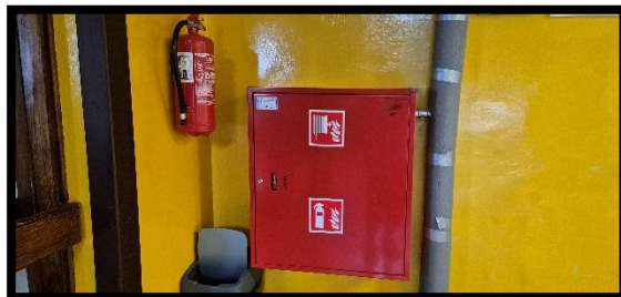
instalacja hydrantowa wewnątrz budynku PSP nr 5
