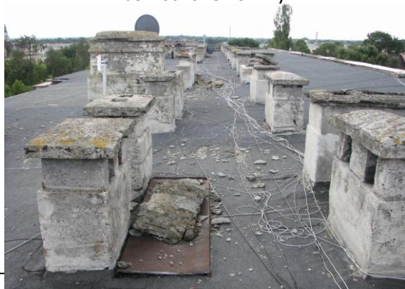
Fot. 21. Zniszczone kominy ponad dachem
