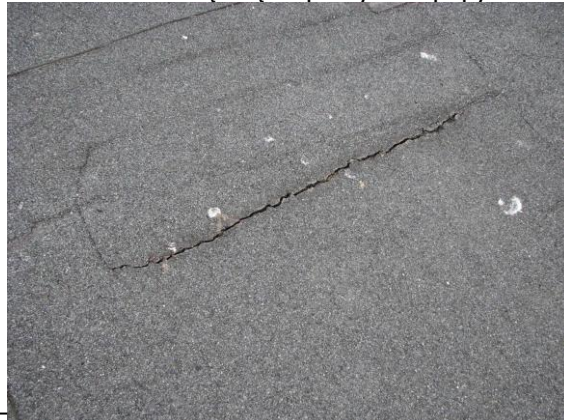
Fot. 24. Pęknięcia pokrycia z papy
