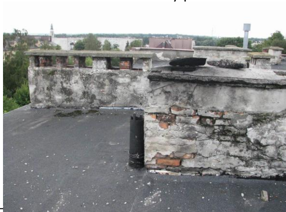
Fot. 23. Nierówności rynien, zanieczyszczenia
