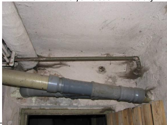
Fot. 32. Prowizoryczne odcinki instalacji
