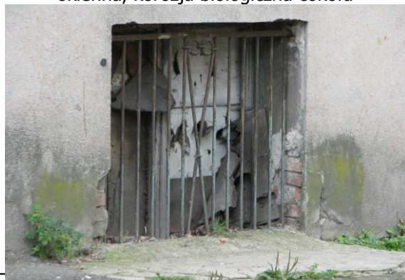
Fot. 7. Korozja biologiczna cokołu, nierówności i uszkodzenia opaski wokół budynku
