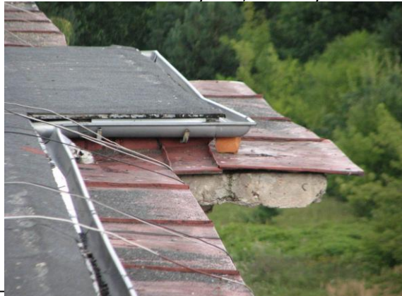
Fot. 23. Nierówności rynien, zanieczyszczenia
