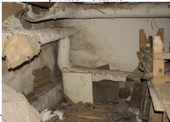
Fot. 31. Żeliwne instalacje kanalizacji
