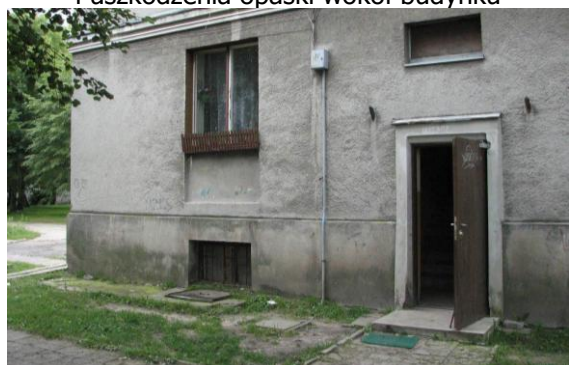
Fot. 7. Korozja biologiczna cokołu, nierówności i uszkodzenia opaski wokół budynku
