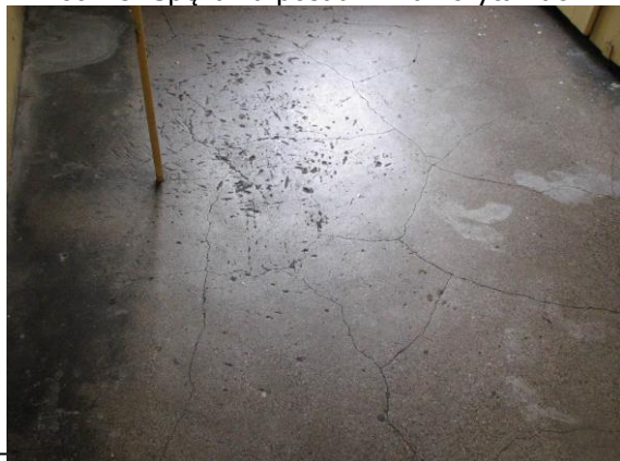
Fot. 15. Spękania posadzki na korytarzach
