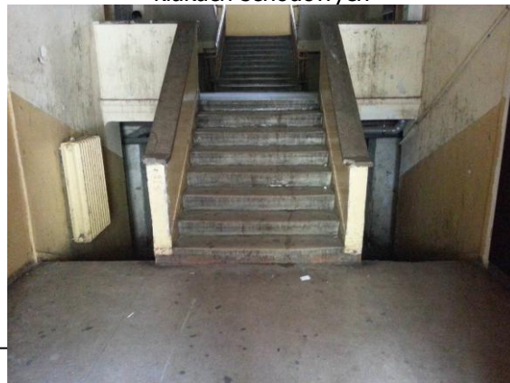
Fot. 16. Zniszczone powłoki malarskie i tynki na kłakach schodowych
