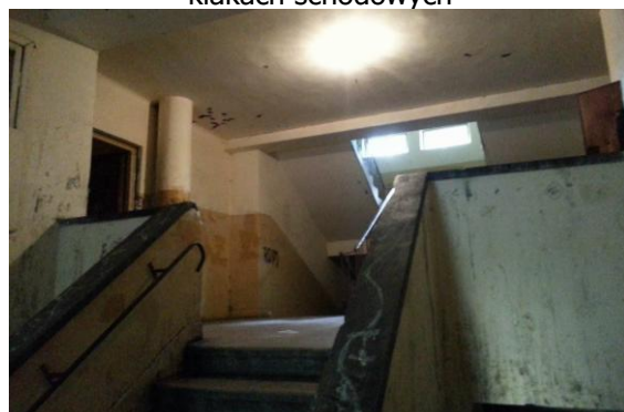
Fot. 8. Zniszczone powłoki malarskie i tynki na kłakach schodowych
