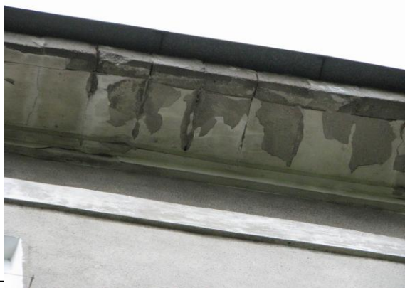
Fot. 3. Odsłonięte cegły ścian zewnętrzny i uszkodzone gzymsy
