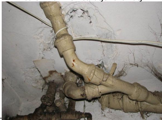
Fot. 31. Żeliwne instalacje kanalizacji
