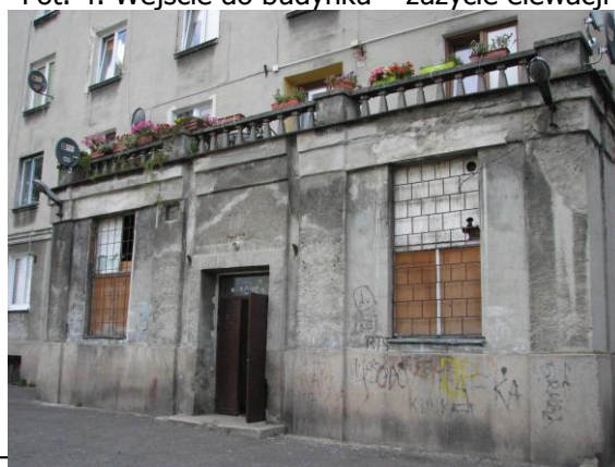
Fot. 6. Zniszczona stolarka okienna, przemarznięte tynki
