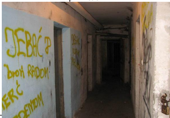
Fot. 11. Zniszczone powłoki malarskie i tynki w piwnicach
