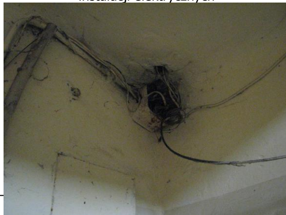
Fot. 32. Nieodpowiedni zabezpieczone puszek instalacji elektrycznych
