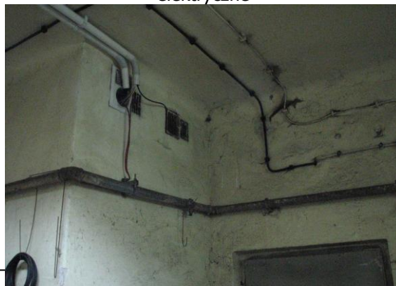
Fot. 32. Nieodpowiedni zabezpieczone puszek instalacji elektrycznych
