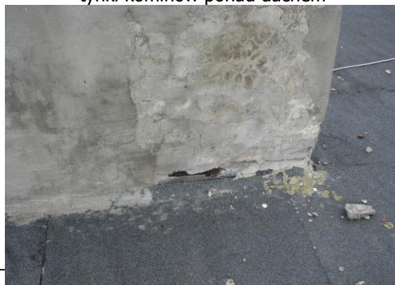
Fot. 14. Wyeksploatowane i kominy ponad dachem, nieuporządkowane kable
