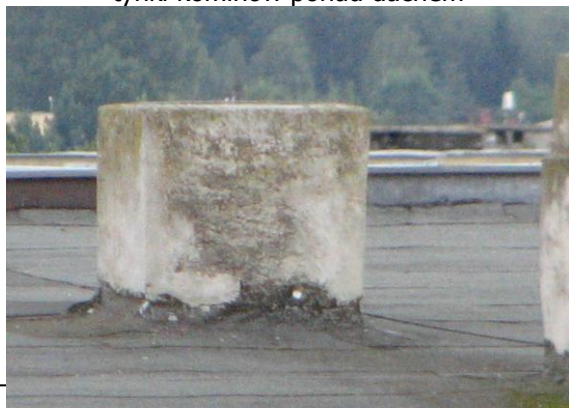
Fot. 15. Korozja biologiczna na dachu
