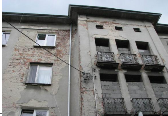
Fot. 4. Zamurowane wejścia na balkony
