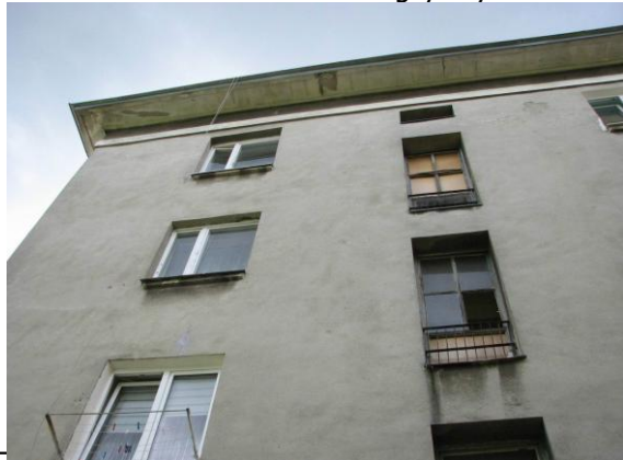
Fot. 7. Uszkodzone gzymsy
