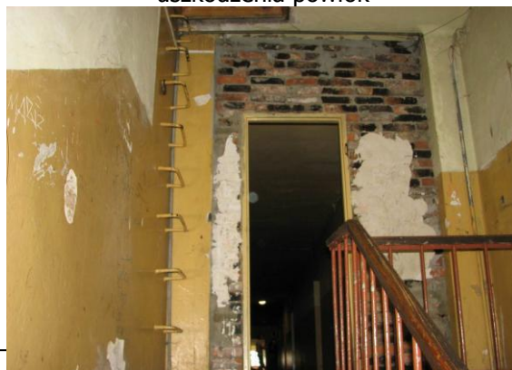
Fot. 22. Zniszczone wykończenia pomieszczeń wspólnych – wc
