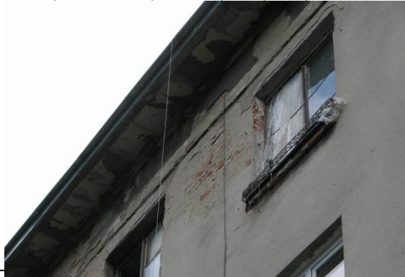
Fot. 3. Odślonięte cegły ścian zewnętrznych i uszkodzone gzymsy
