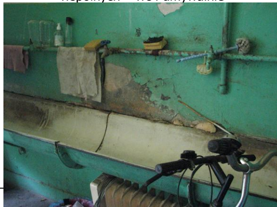
Fot. 24. Zniszczone wykończenia pomieszczeń wspólnych – wc i umywalnie
