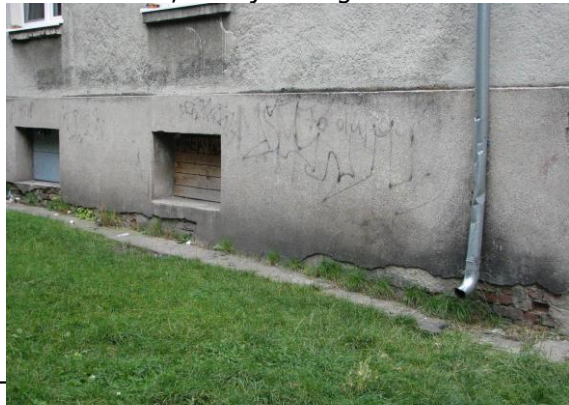
Fot. 7. Uszkodzone gzymsy
