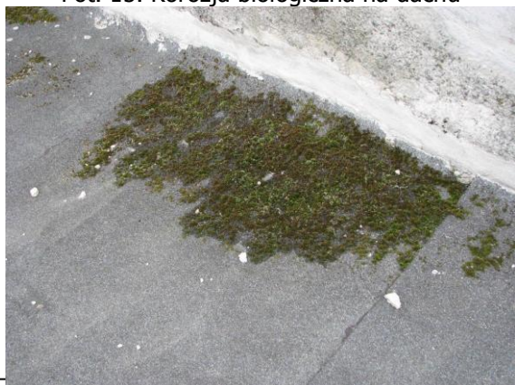
Fot. 15. Korozja biologiczna na dachu
