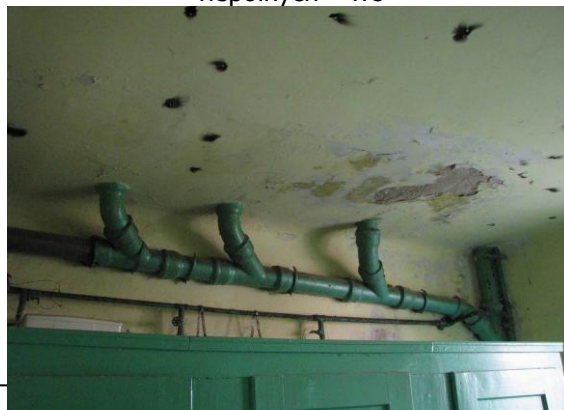
Fot. 24. Zniszczone wykończenia pomieszczeń wspólnych – wc i umywalnie
