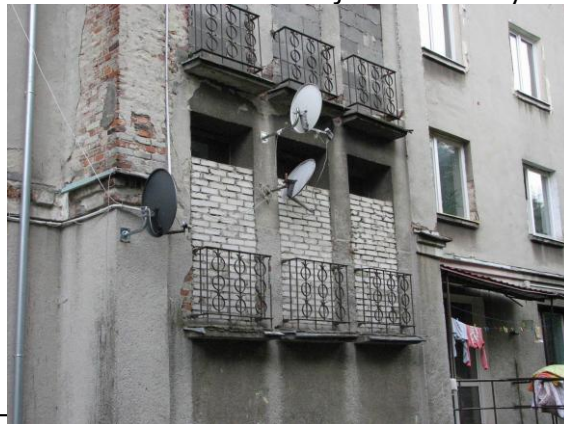
Fot. 6. Przemarznęte tynki elewacji
