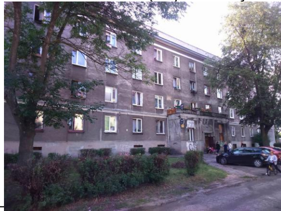
Fot. 8. Przemarznęte tynki elewacji
