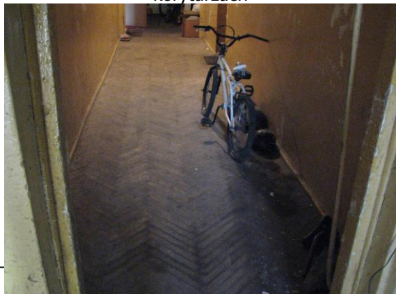
Fot. 23. Wyeksploatowane klepki podłogowe na korytarzach
