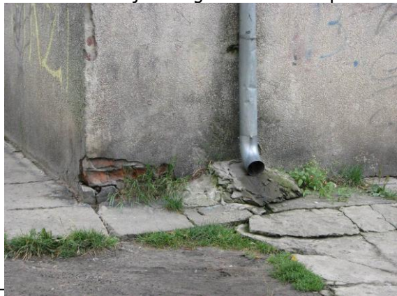
Fot. 11. Odsłonięte cegły ścian zewnętrznych i uszkodzone gzymsy
