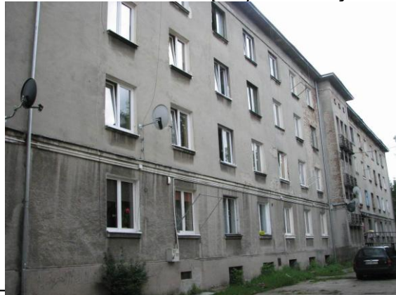
Fot. 8. Przemarznęte tynki elewacji
