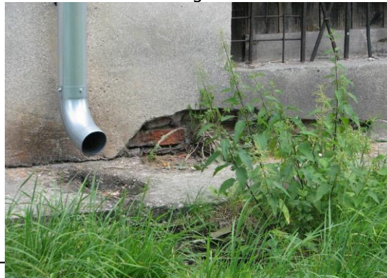
Fot. 8. Ubytki i przemarzanie gzymsów
