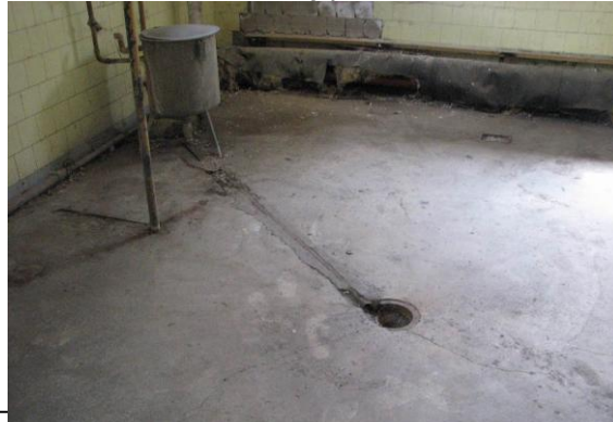
Fot. 52. Ogniska korozji rur stalowych instalacji oraz braki otulin izolacyjnych
