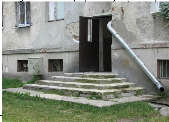
Fot. 6. Ubytki tynku cokołów, korozja biologiczna
