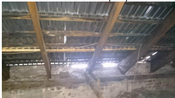
Fot. 31. Więźba dachowa – zawilgocenia oraz uszkodzenia mechaniczne i wyeksploatowania oraz nieszczelności pokrycia
