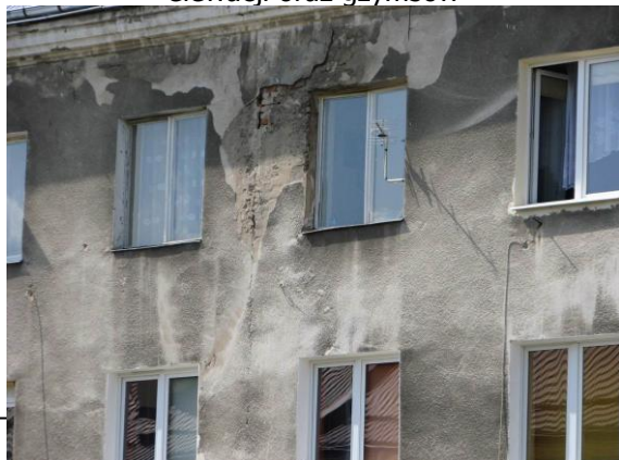
Fot. 15. Liczne ubytki i przemarzanie tynków elewacji oraz gzymsów
