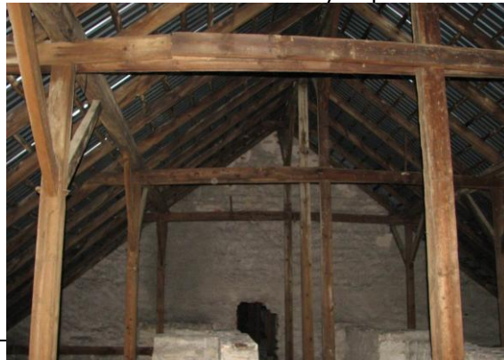
Fot. 38. Zanieczyszczenia na poddaszu powodujące zagrożenie pożarowe
