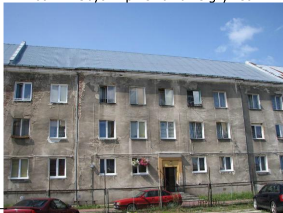
Fot. 16. Zwietrzała elewacja, silna korozja pokrycia dachowego
