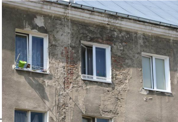
Fot. 3. Zniszczona stolarka okienna i postępująca korozja krat
