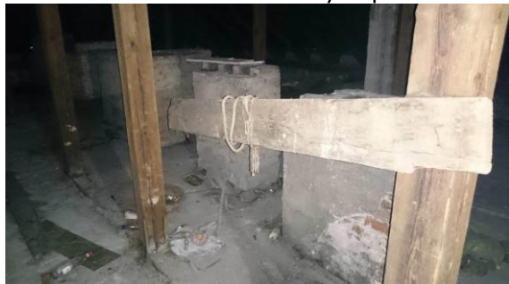
Fot. 25. Więźba dachowa – zawilgocenia oraz uszkodzenia mechaniczne i wyeksploatowania
