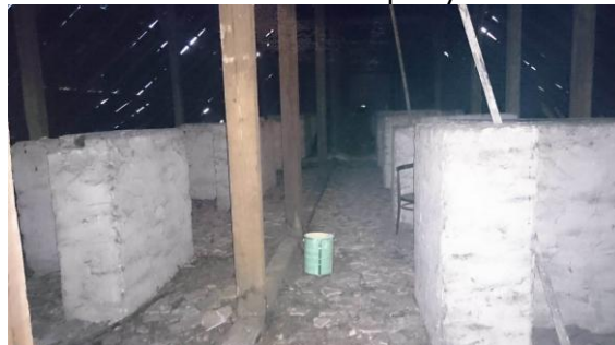
Fot. 28. Więźba dachowa – zawilgocenia oraz uszkodzenia mechaniczne i wyeksploatowania oraz nieszczelności pokrycia
