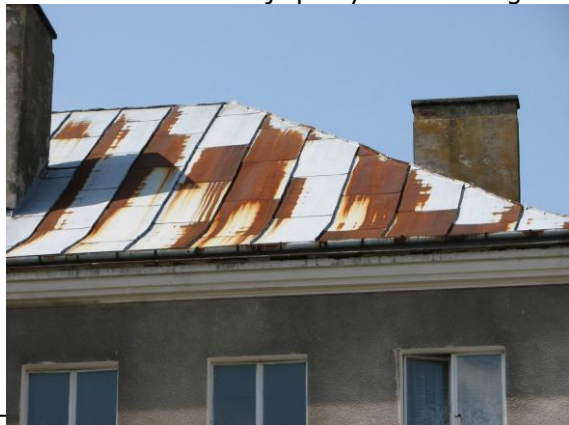
Fot. 19. Zwiertzałe tynki kominów, ubytki oraz korozja biologiczna
