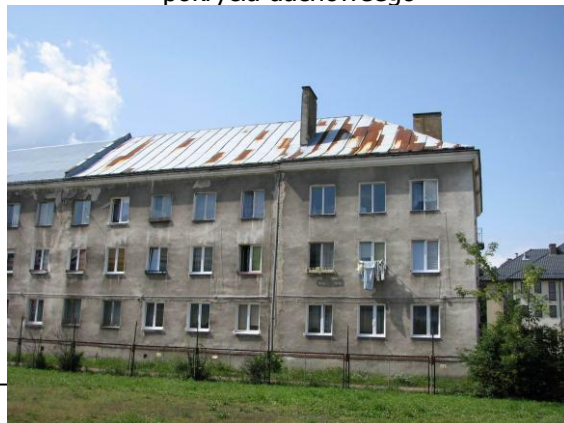
Fot. 16. Zwietrzała elewacja, silna korozja pokrycia dachowego
