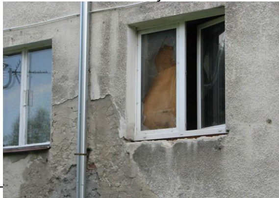
Fot. 7. Ubytki tynku elewacji. Wyeksploatowane luksfery na klatce schodowej środkowej
