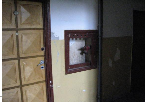
Fot. 55. Braki otulin i korozja rur instalacyjnych
