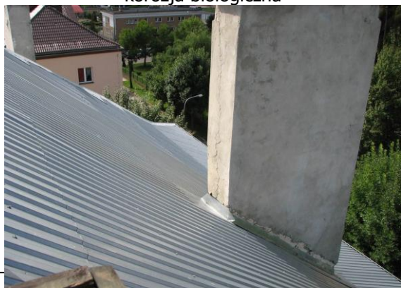
Fot. 21. Korozja biologiczna oraz uszkodzenia kominów ponad dachem
