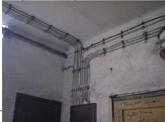
Fot. 56. Stare instalacje elektryczne w poziomie piwnic
