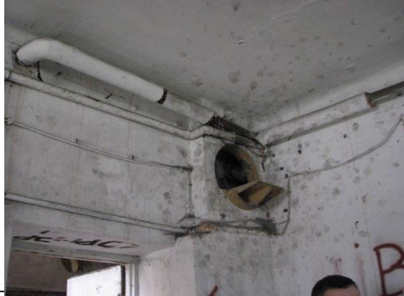
Fot. 55. Braki otulin i korozja rur instalacyjnych
