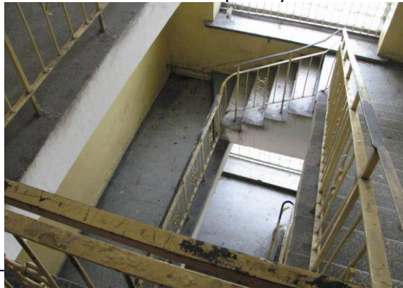
Fot. 47. Zacieki na ścianach klatki schodowej
