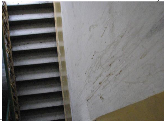
Fot. 47. Zacieki na ścianach klatki schodowej
