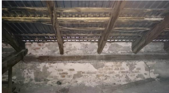
Fot. 33. Więźba dachowa – zawilgocenia oraz uszkodzenia mechaniczne i wyeksploatowania
