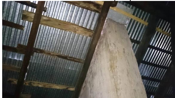
Fot. 32. Więźba dachowa – zawilgocenia oraz uszkodzenia mechaniczne i wyeksploatowania
