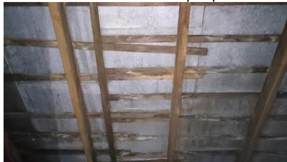
Fot. 26. Więźba dachowa – zawilgocenia oraz uszkodzenia mechaniczne i wyeksploatowania
