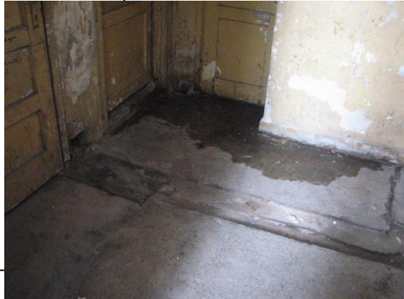
Fot. 39. Wyeksploatowane ścianki działowej piwnic oraz stolarka
