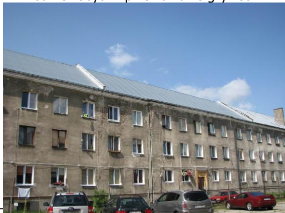
Fot. 15. Liczne ubytki i przemarzanie tynków elewacji oraz gzymsów
