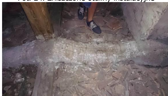
Fot. 24. Zniszczone otuliny instalacyjne
