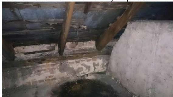
Fot. 27. Więźba dachowa – zawilgocenia oraz uszkodzenia mechaniczne i wyeksploatowania
