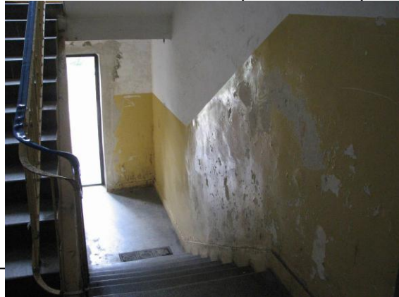
Fot. 40. Klatki schodowe – liczne uszkodzenia mechaniczne i zniszczenia powłok ściennych
