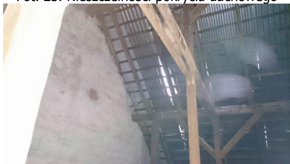
Fot. 23. Nieszczelności pokrycia dachowego
