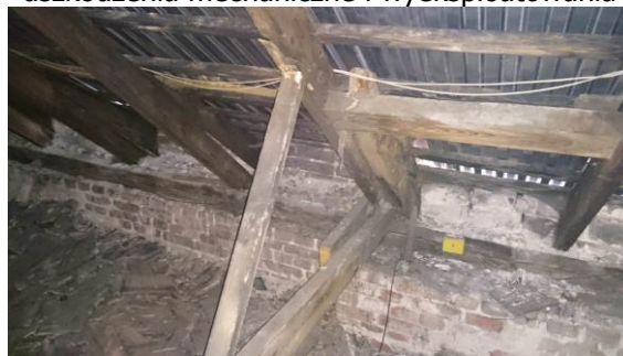
Fot. 22. Więźba dachowa – zawilgocenia oraz uszkodzenia mechaniczne i wyeksploatowania
