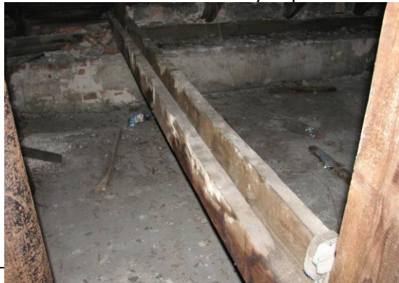
Fot. 37. Więźba dachowa – zawilgocenia oraz uszkodzenia mechaniczne i wyeksploatowania
