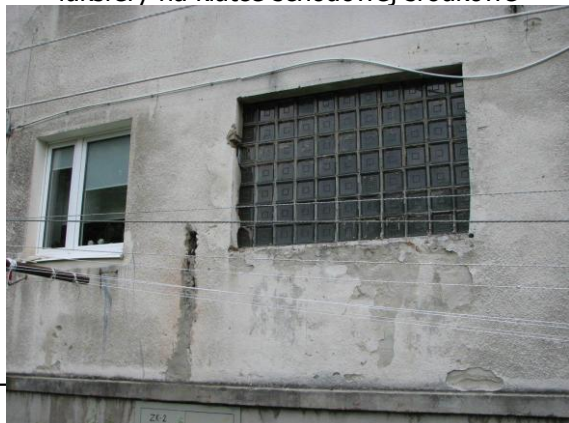
Fot. 7. Ubytki tynku elewacji. Wyeksploatowane luksfery na klatce schodowej środkowej
