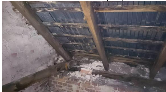
Fot. 29. Więźba dachowa – zawilgocenia oraz uszkodzenia mechaniczne i wyeksploatowania
