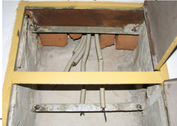
Fot. 56. Stare instalacje elektryczne w poziomie piwnic
