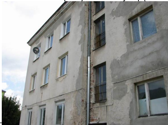
Fot. 11. Ubytki i przemarzanie gzymsów oraz ubytki otuliny od spodu płyt balkonowych
