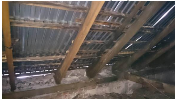
Fot. 30. Więźba dachowa – zawilgocenia oraz uszkodzenia mechaniczne i wyeksploatowania oraz nieszczelności pokrycia
