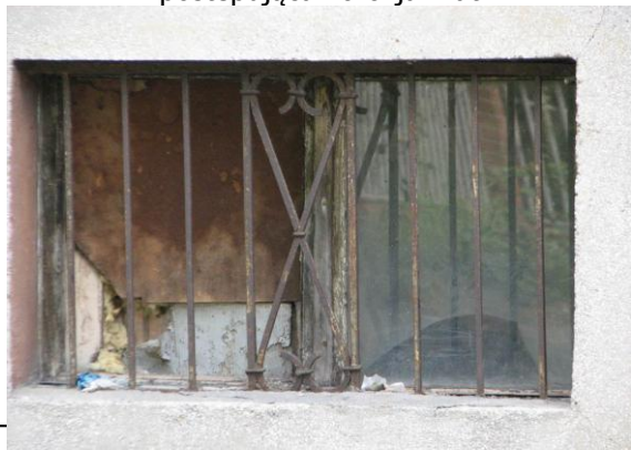
Fot. 5. Wybite szyby w oknach, ubytki tynku elewacji
