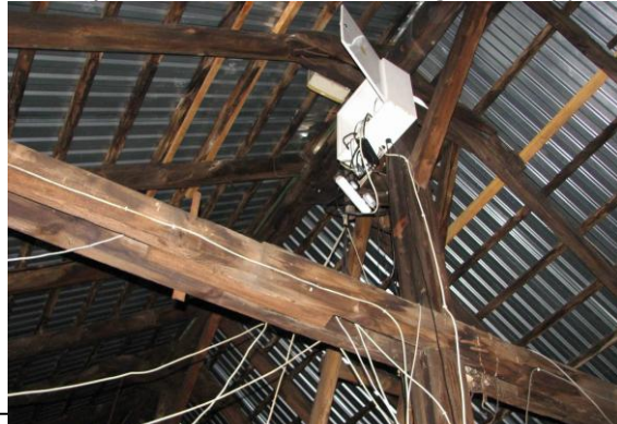
Fot. 36. Więźba dachowa – zawilgocenia oraz uszkodzenia mechaniczne i wyeksploatowania
