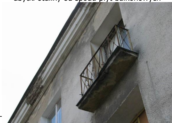
Fot. 13. Ubytki i przemarzanie gzymsów
