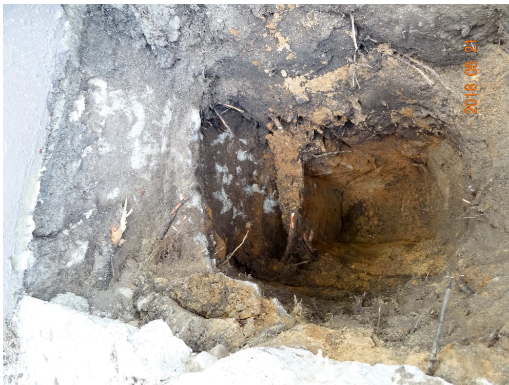
Bud. "A"- odkrywka fundamentu i muru fundamentowego
