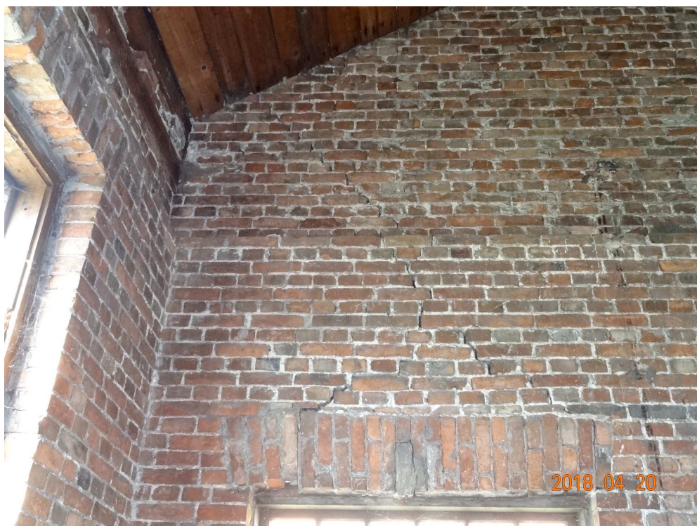
Bud. "C"- pęknięte nadproże i ściana w ścianie szczytowej od strony zachodniej
