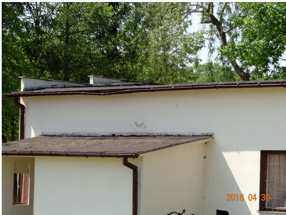
Bud. "A" - widok uszkodzenia rynny strony północno- wschodniej
