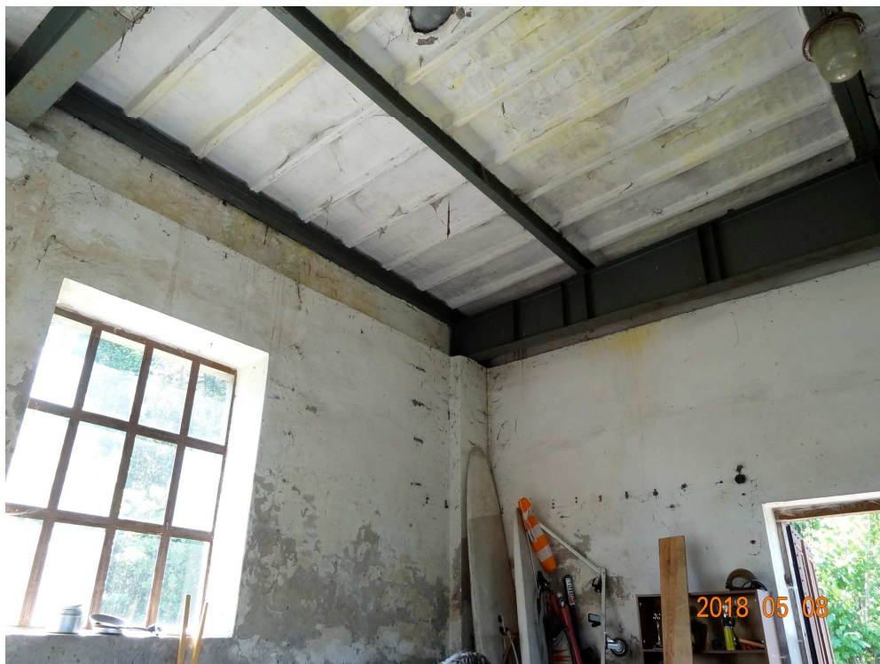
Bud. "B"- uszkodzenia ściany i stropodachu od strony południowo- zachodniej
