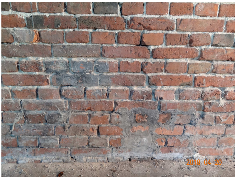
Bud. "C" - uszkodzenia ścian w części przemysłowej od strony południowej
