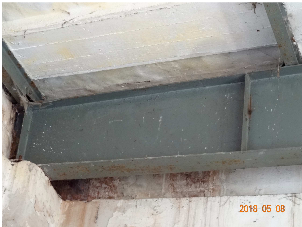
Bud. "B"- dźwigar dachowy stalowy- blachownica spawana- widok części przypodporowej
