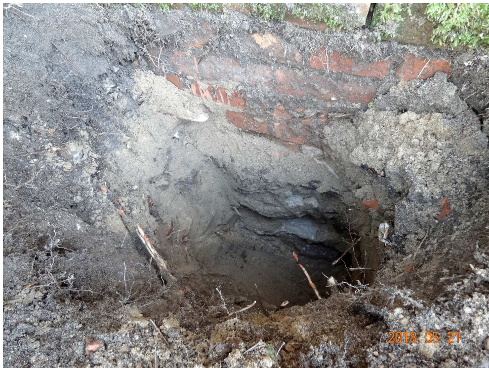
Bud. "B"- odkrywka fundamentu i muru fundamentowego
