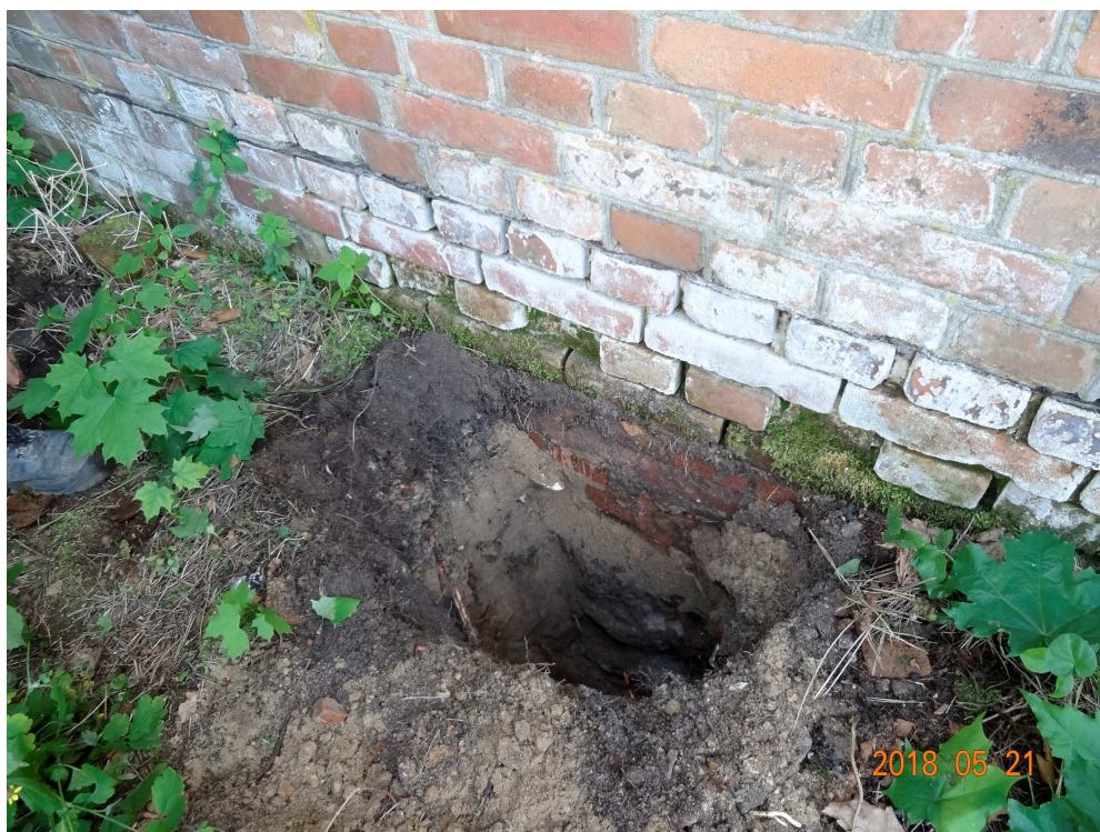
Bud. "B"- odkrywka fundamentu i muru fundamentowego
