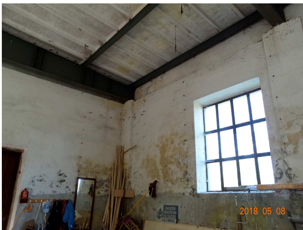
Bud. "B"- uszkodzenia ściany i stropodachu od strony północno- zachodniej
