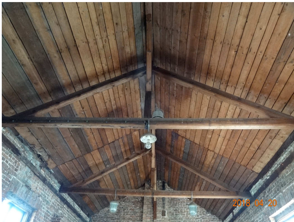
Bud. "C"- widok ugięcia dźwigara drewnianego dachowego w części przemysłowej
