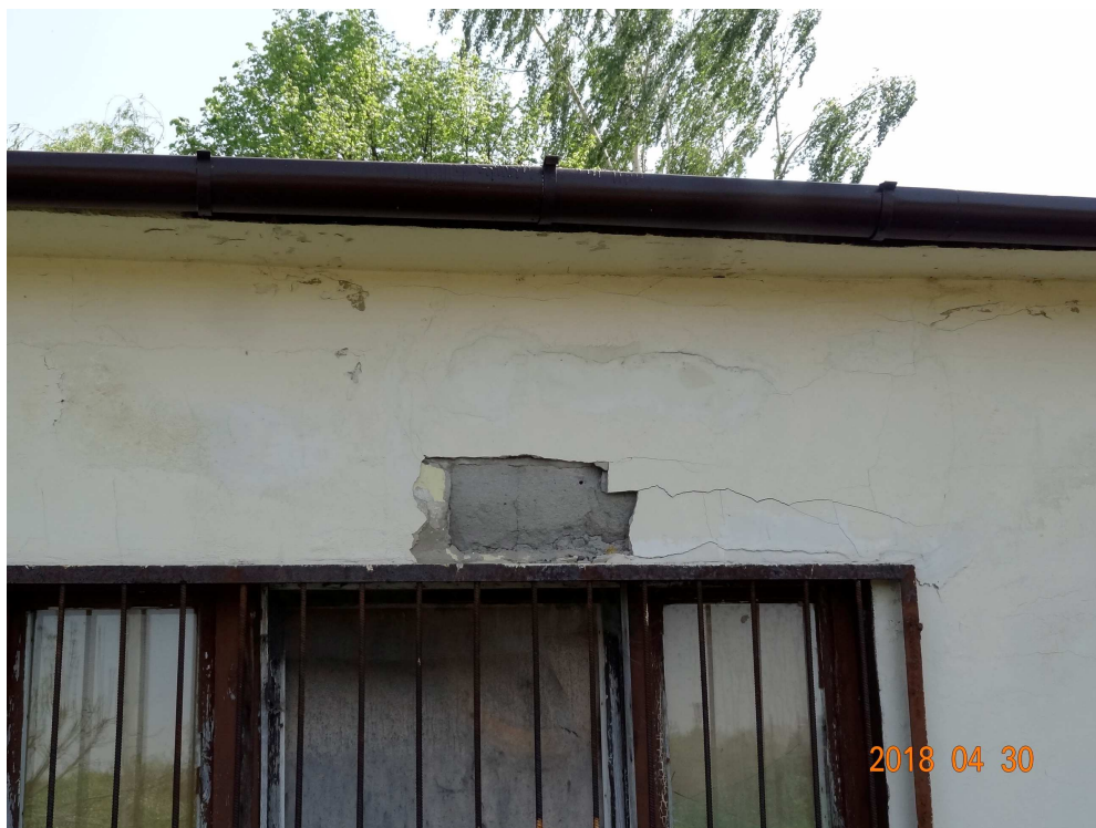
Bud. "A"- widok uszkodzenia ściany i nadproża od strony północno- zachodniej
