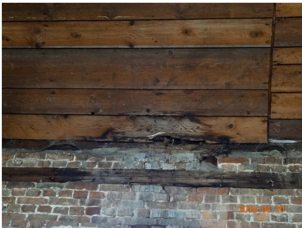
Bud. "C"- zniszczenia podbitki dachu z desek i murłaty
