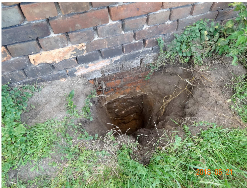
Bud. "C"- odkrywka fundamentów i muru fundamentowego w części mieszkalnej
