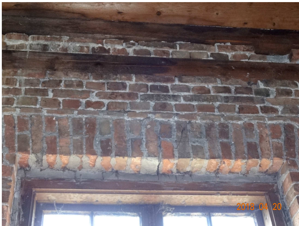
Bud. "C"- pęknięte nadproże nad oknem w części przemysłowej od strony południowej
