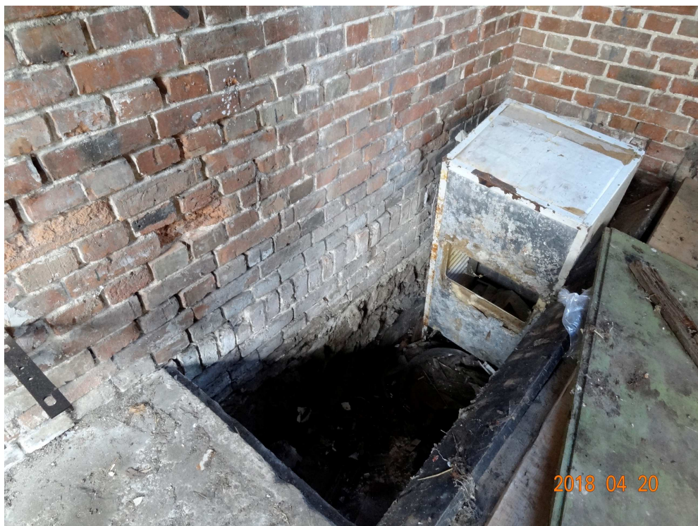
Bud. "C"- uszkodzenia ścian i kanał technologiczny w części przemysłowej
