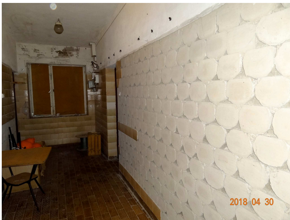
Bud. "A" - ubytki w okładzinie ściany z płytek ceramicznych, uszkodzenia nadproża nad oknem i ściany, okno zabezpieczone sklejką i płytą pilśniową
