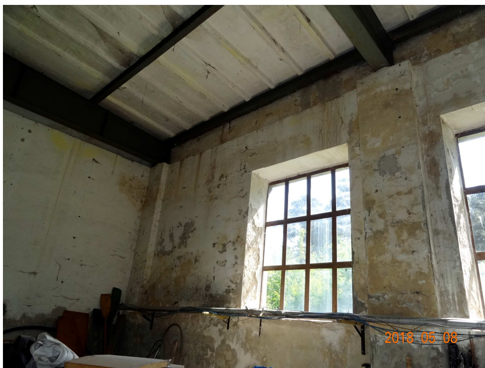
Bud. "B"- uszkodzenia ściany i stropodachu od strony południowo- wschodniej
