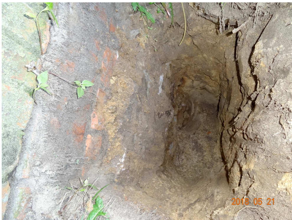
Bud. "C"- odkrywka fundamentów i muru fundamentowego w części mieszkalnej
