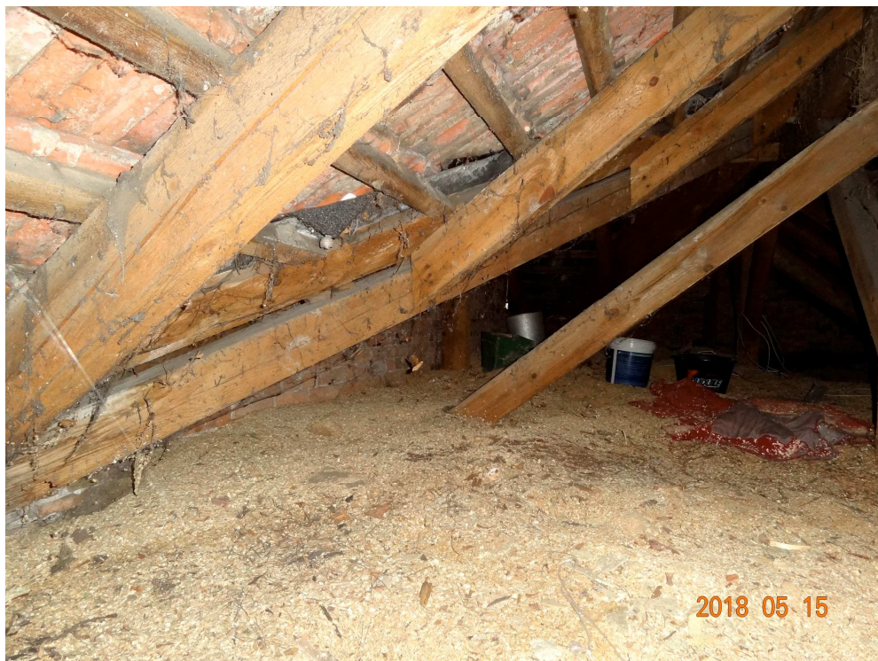
Bud. "C"- konstrukcja dachu nad częścią mieszkalną- krokwie, łąty, zastrzały
