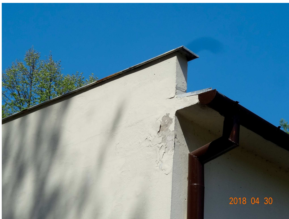
Bud. "A" - widok uszkodzenia przy gzymsie strony północno- wschodniej
