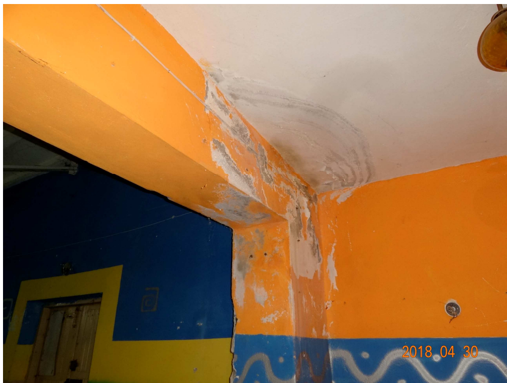
Bud. "A"- widok uszkodzenia ściany i stropodachu przy połączeniu części niższej i wyższej
