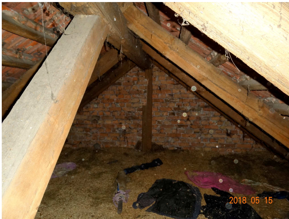
Bud. "C"- konstrukcja dachu nad częścią mieszkalną- krokwie, zastrzały, płatew
