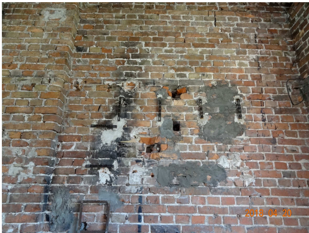
Bud. "C"- uszkodzenia i ubytki ściany od wewnątrz pomieszczenia w części przemysłowej
