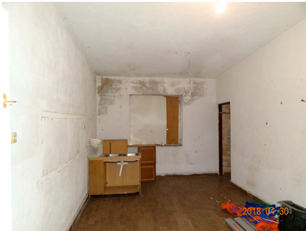
Bud. "A"- uszkodzenia nadproża nad oknem, ściany, stropodachu, okno zabezpieczone sklejką i płytą pilśniową
