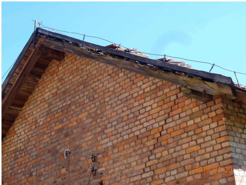
Bud. "C"- pęknięcia w ścianie szczytowej i zniszczony dach w cz. przemysłowej od strony południowo- zachodniej
