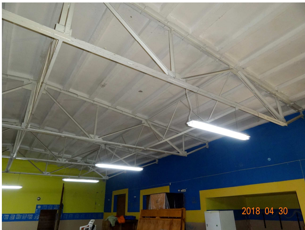
Bud. "A"- widok konstrukcji dźwigara dachowego kratowego i przekrycia dachu z płytek korytkowych
