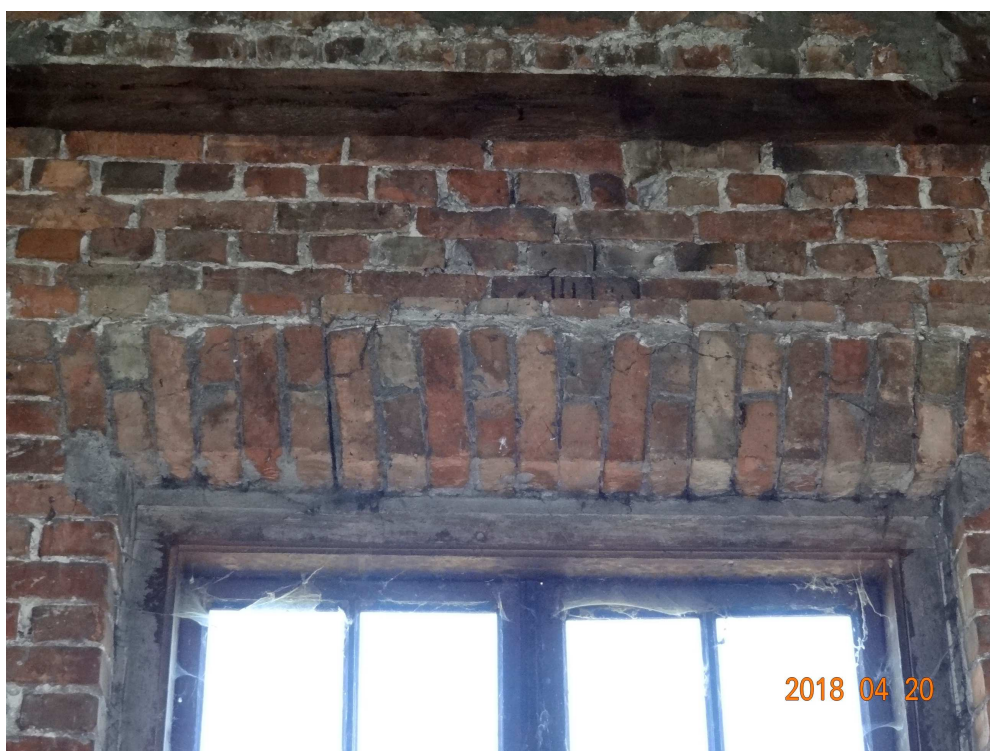
Bud. "C"- pęknięte nadproże nad oknem w części przemysłowej od strony północnej
