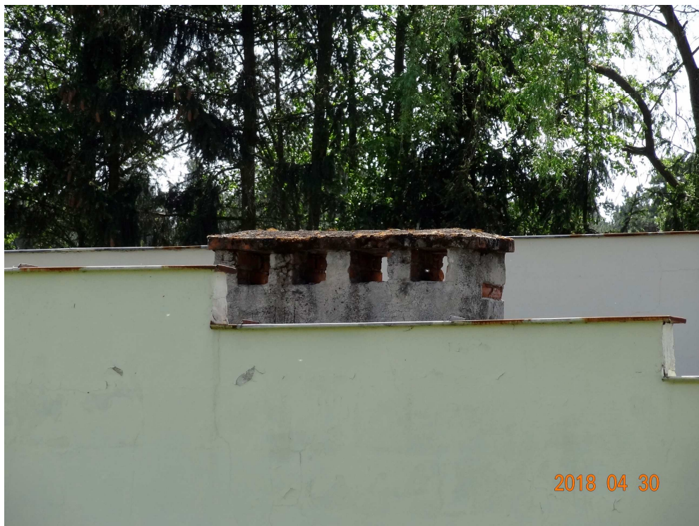
Bud. "A"- widok uszkodzeń komina na dachu od strony północno- zachodniej
