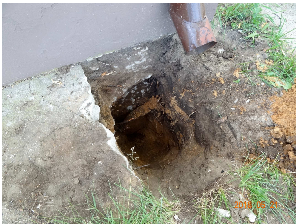
Bud. "A"- odkrywka fundamentu i muru fundamentowego
