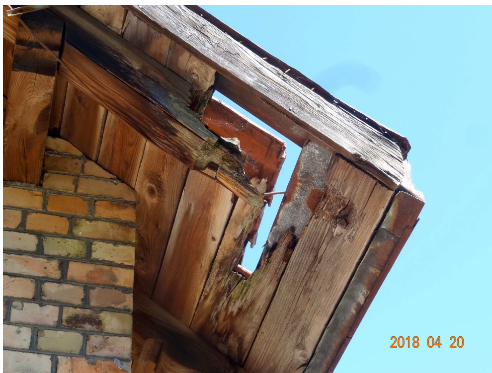
Bud. "C"- zniszczony okap dachu w części mieszkalnej od strony południowo- zachodniej
