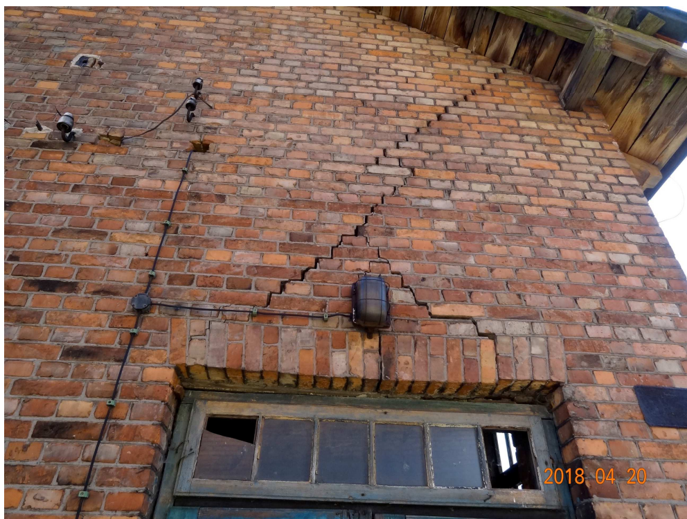
Bud. "C"- pęknięcia nadproża n/drzwiami i ściany w ścianie szczytowej zachodniej w części przemysłowej
