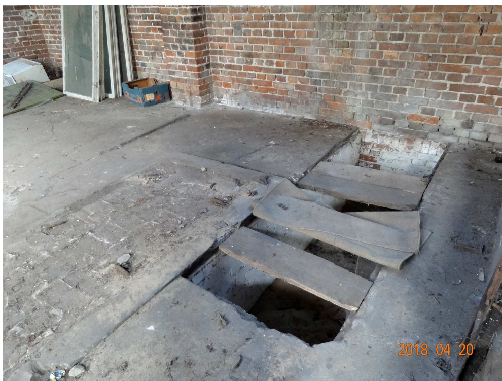
Bud. "C"- uszkodzenia ścian i kanały technologiczne w części przemysłowej
