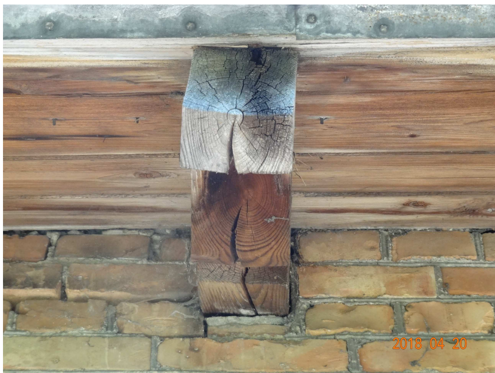
Dud. "C"- uszkodzenie krokwi i podbitki dachu w cz. mieszkalnej od strony wschodniej
