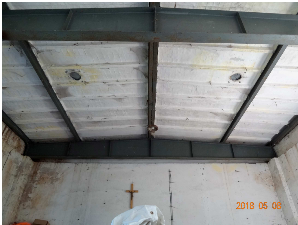
Bud. "B"- widok konstrukcji dźwigara dachowego i przekrycia z płyt korytkowych
