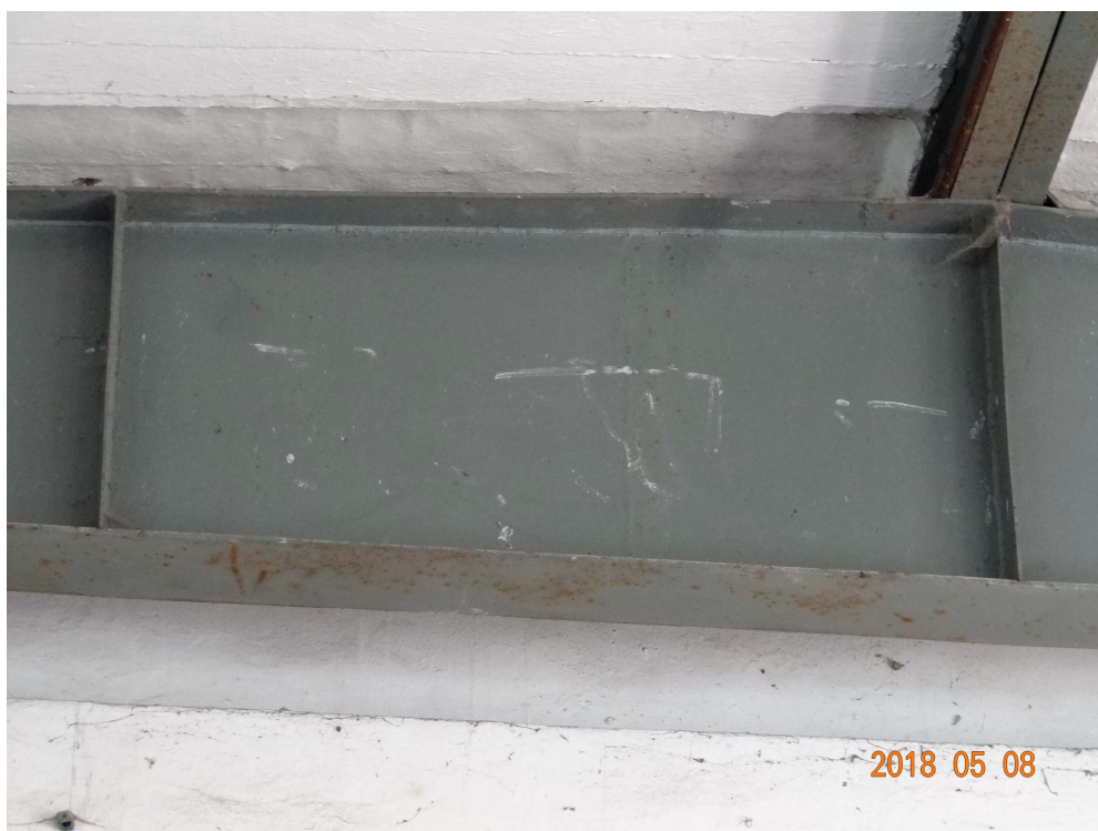
Bud. "B"- dźwigar dachowy stalowy- blachownica spawana- widok części środkowej
