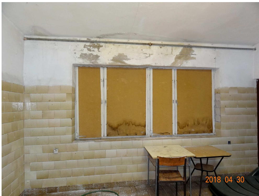
Bud. "A"- uszkodzenie nadproża, ściany, stropodachu w pomieszczeniu technicznym
