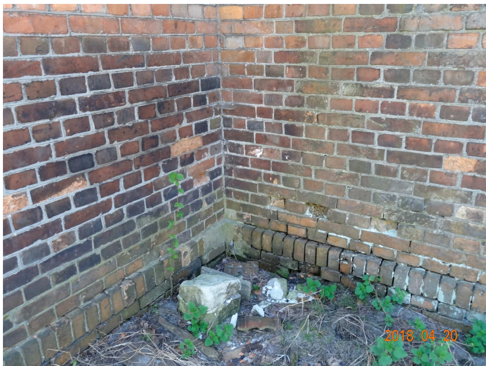
Bud. "C"- uszkodzenia ścian zewnętrznych od strony północnej
