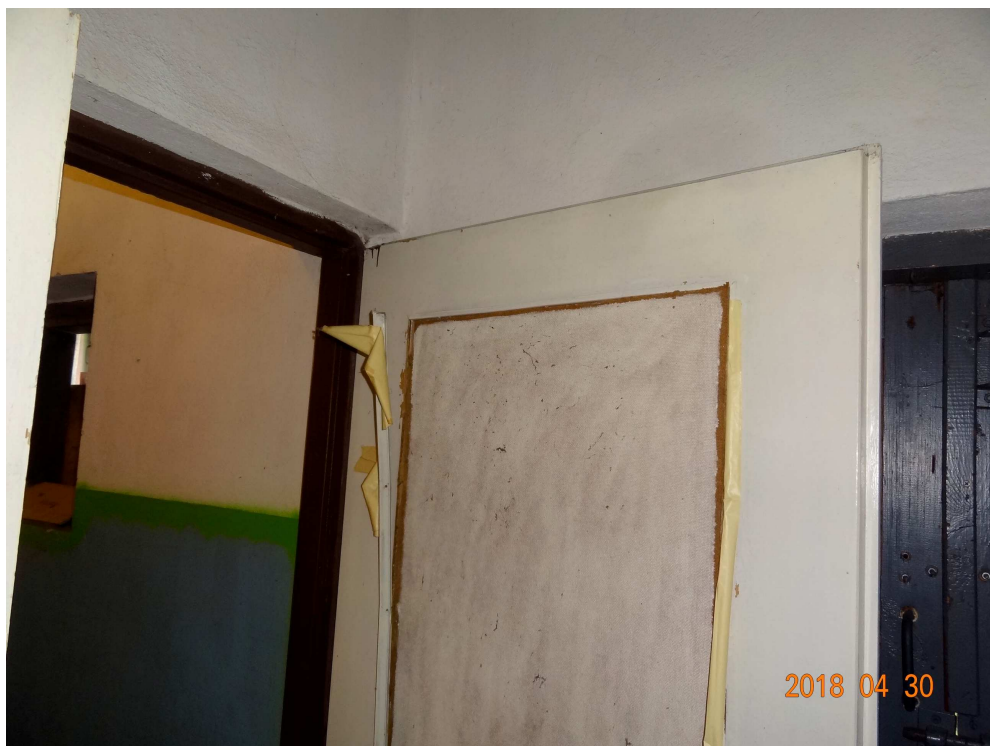
Bud. "A"- uszkodzenia drzwi wewnętrznych i futryn
