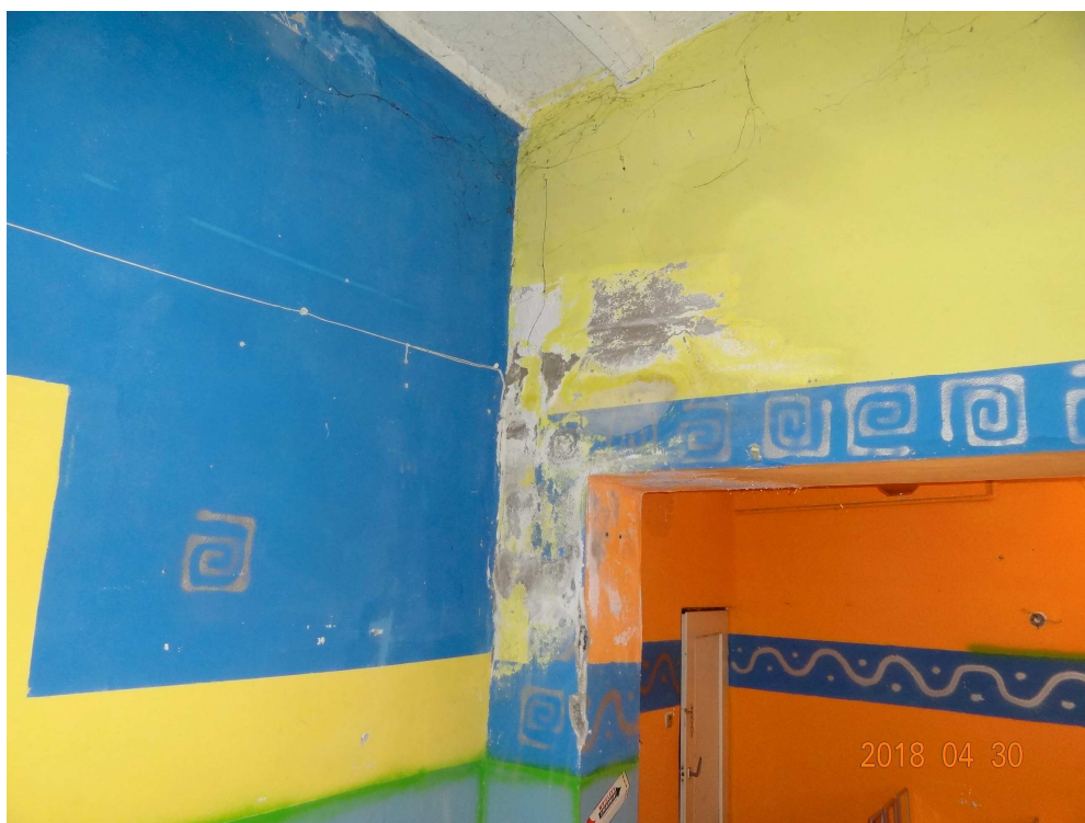
Bud. "A"- widok uszkodzenia ścian w pomieszczeniu magazynowym
