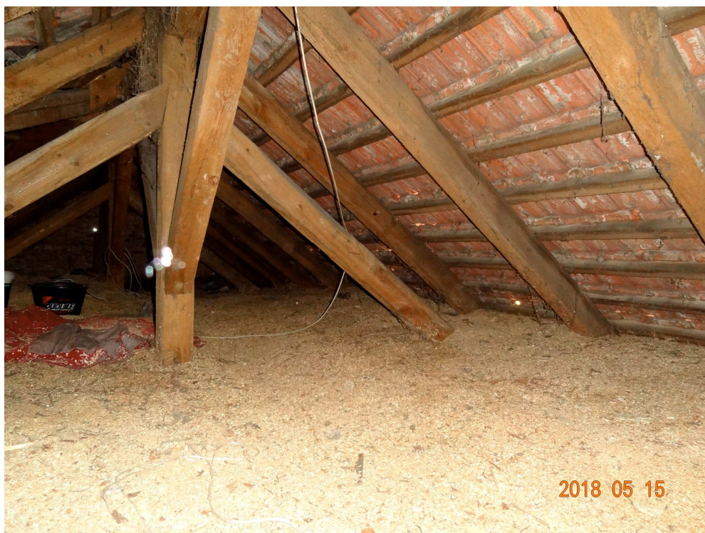
Bud. "C" - konstrukcja dachu nad częścią mieszkalną- krokwie, słupy, zastrzały
