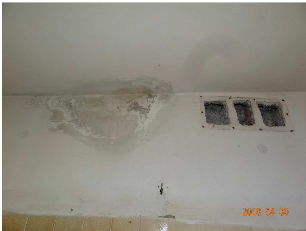
Bud. "A"- uszkodzenia przy kominie w części niższej w pomieszczeniu technicznym
