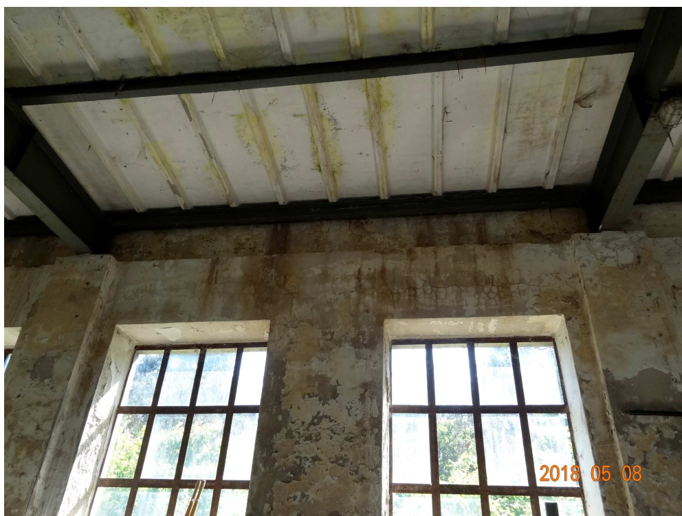
Bud. "B"- uszkodzenia ściany i stropodachu od strony południowej
