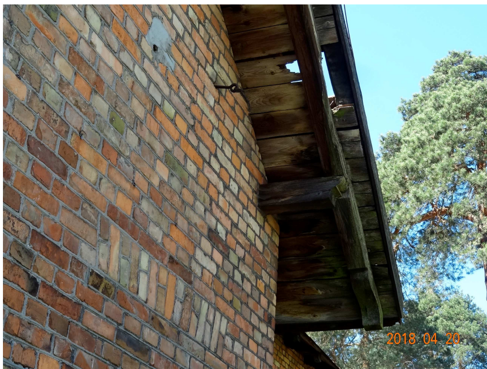
Bud. "C"- zniszczony dach w części mieszkalnej od strony północnej
