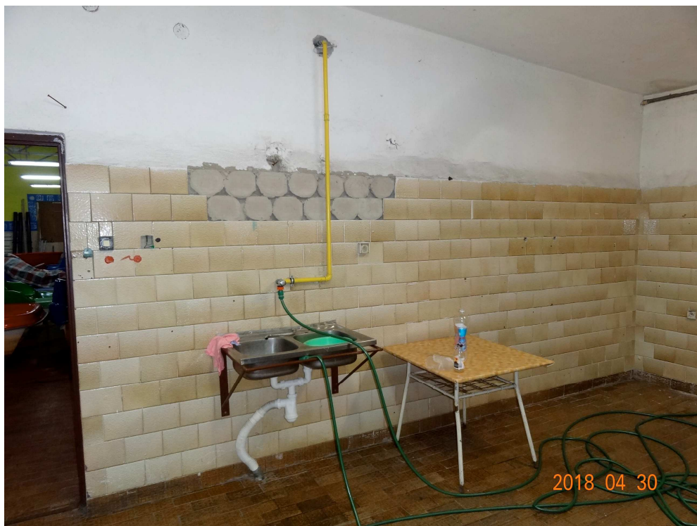
Bud. "A" - ubytki w okładzinie ściany z płytek ceramicznych
