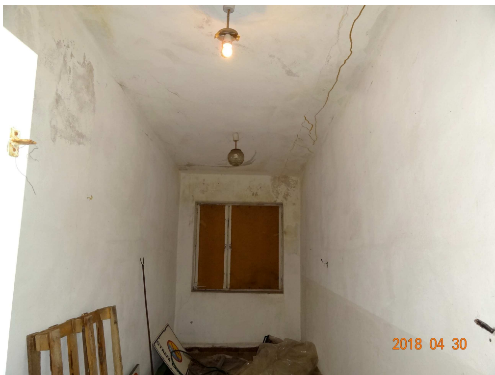
Bud. "A"- pęknięcie wzdłużne w stropodachu pomiędzy płytami stropowymi kanałowymi
