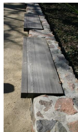
MURKI KRAJOBRAZOWE OPOROWE Z KAMIENIA POLNEGO ŁAMANEGO Z WBUDOWANYMI SIEDZISKAMI DREWNO – MODRZEW SYBERYJSKI OLEJOWANY, SZER.. 60CM, KONSTRUKCJA: TRZPIEŃ BETONOWY
