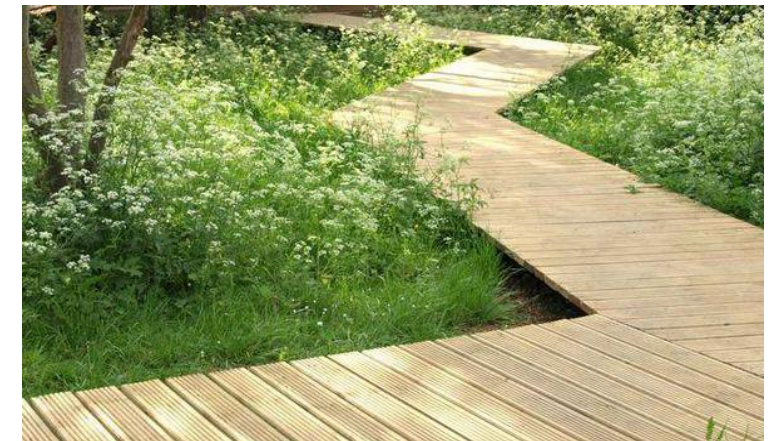
TRAPY DREWNIANE -DREWNO IMPREGNOWANE CIŚNIENIOWO (MODRZEW SYBERYJSKI) NA KONSTRUKCJI STALOWEJ
