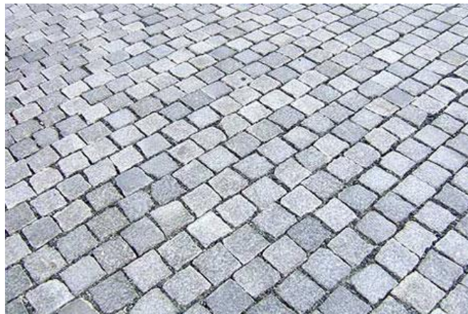
NAWIERZCHNIA Z KOSTKI GRANITOWEJ CIĘTEK JEDNOSTRONNIE, PROD. ZPG STRZEGOM PŁOMIENIOWANA; WYM. 15X15 GR. 5CM, KOLOR: SZARY
