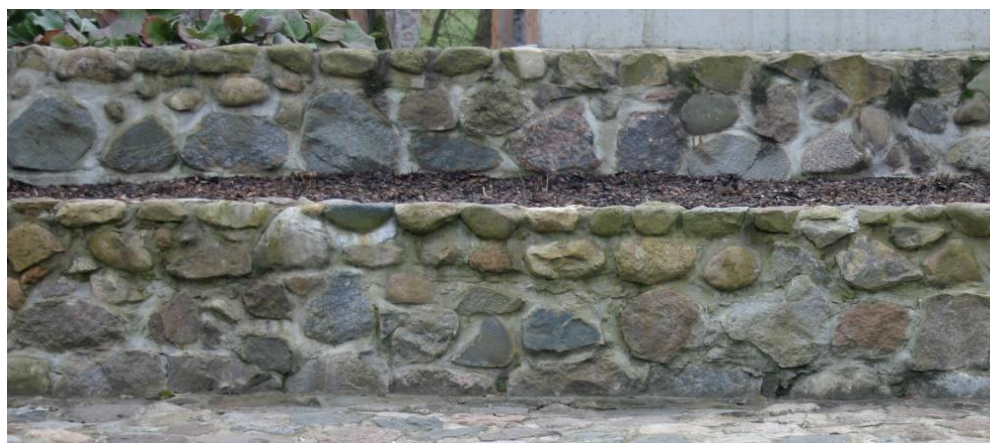
MURKI KRAJOBRAZOWE OPOROWE Z KAMIENIA POLNEGO ŁAMANEGO Z WBUDOWANYMI SIEDZISKAMI DREWNO – MODRZEW SYBERYJSKI OLEJOWANY, SZER.. 60CM, KONSTRUKCJA: TRZPIEŃ BETONOWY
